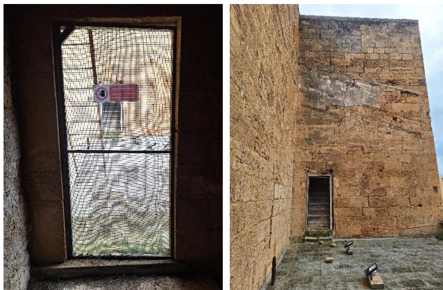
Figura 7 – Dettaglio uscita dell’immobile oggetto di intervento, per accesso al terrazzo esterno lato Sud-Est
