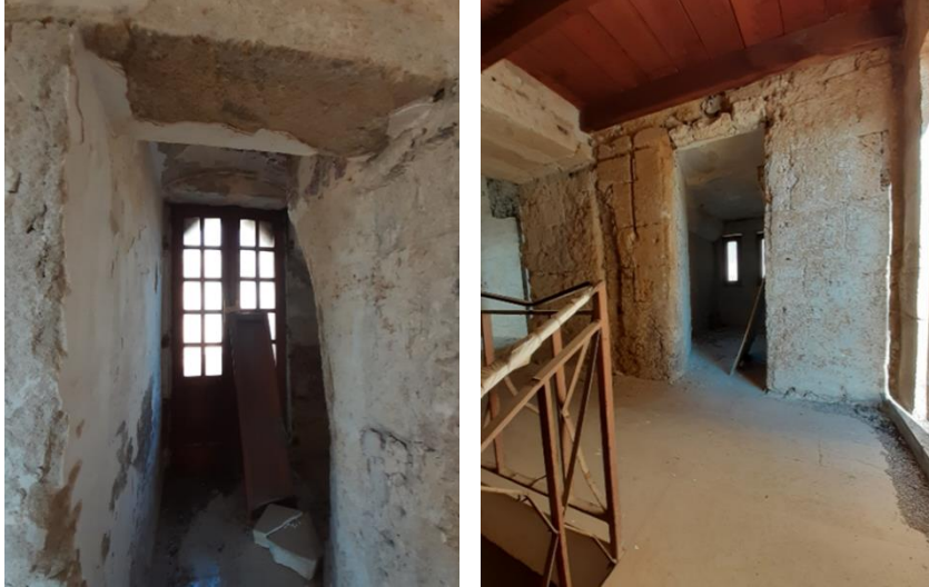
Figura 1 – Dettaglio del vano negli spessori murari e deterioramento dello stesso
