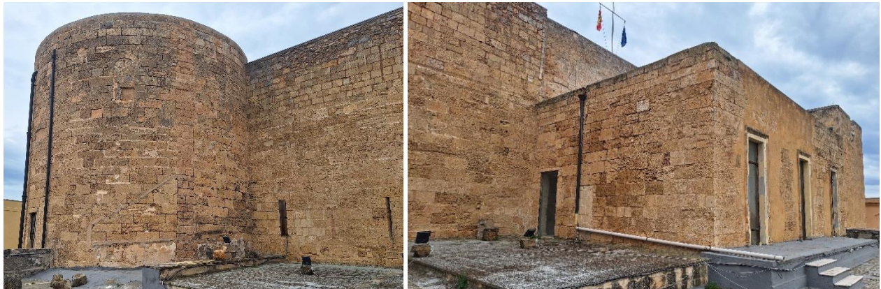
Figura 5 - Terrazzo esterno lato Sud-Ovest
