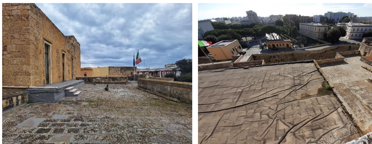
Figura 8 - Terrazzo esterno lato Sud e strati di guaina ormai vetusti in copertura
